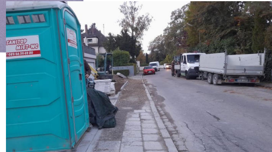
Baustelle als Hindernis
